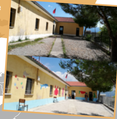
ALBANIË - Fravesh Renovatie schooltje
